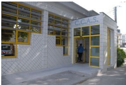
Entrée du CCAS
